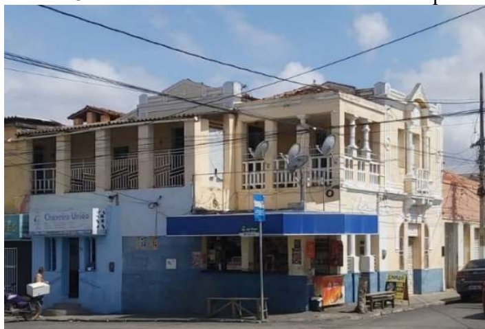
Foto 3 - Casarão da Rua Cosme Ferreira Marques
