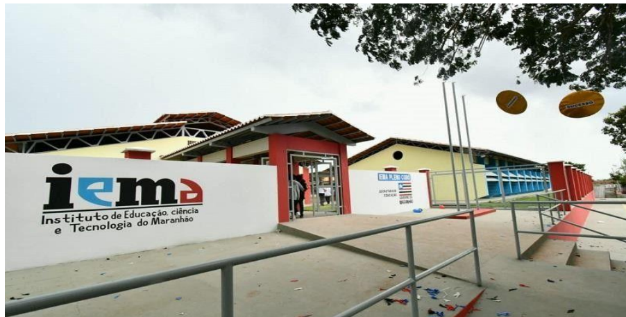
Figura 1. Fachada do Instituto Estadual de Educação, Ciência e Tecnologia do Maranhão – IEMA Pleno, localizado em Codó – MA.
