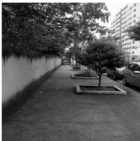
Foto 5 - Tamanho inadequado de canteiro
