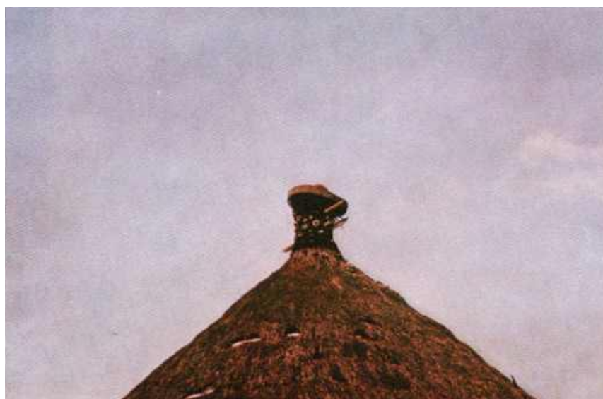
Figura 2 - Telhado da Casa Hulcai
