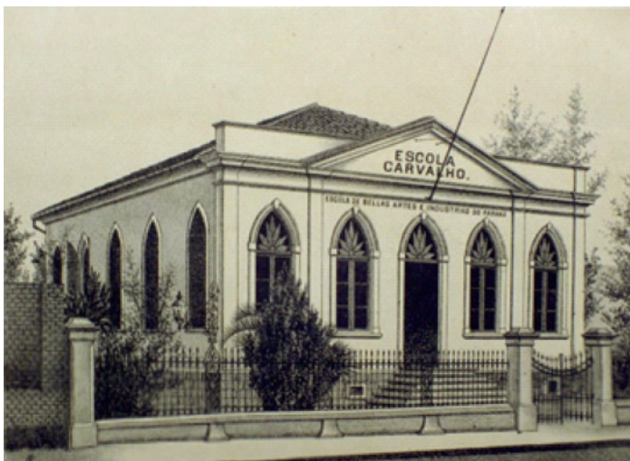
Figura 1 - Fachada da Escola Carvalho
