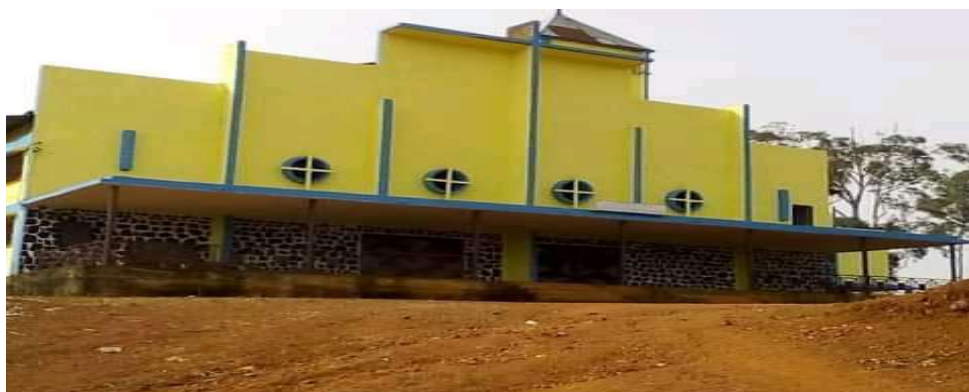
Photo 4 – Vue de face du temple EEC Nda'a Banssié à Foumban.
