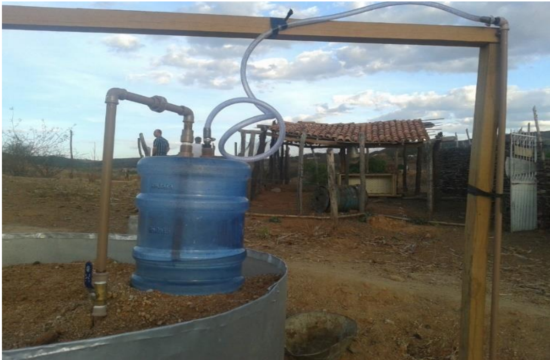
FIGURA 2 – Filtro de garrafão de água mineral instalado sobre a caixa de fibra Fonte: Autora (2015).
