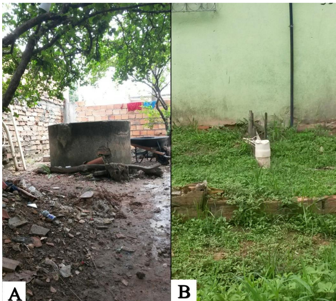
Figura 3 – A- Poço Amazonas. B- Poço tubular. Fonte: Os autores, 2013.
