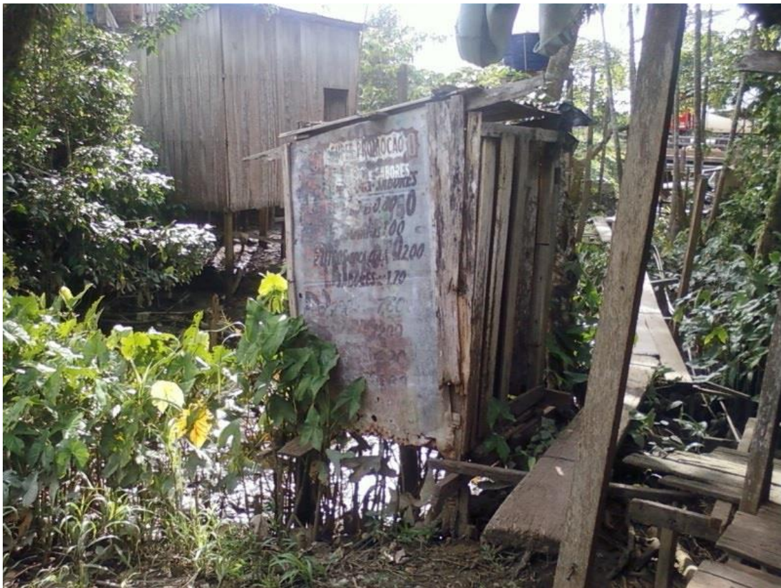
Figura 5 – Sanitário construído no leito do igarapé. Fonte: os autores, 2013.
