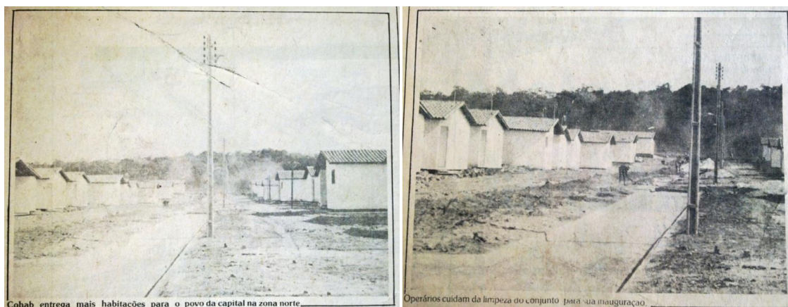
Figuras 3 e 4 – Trecho do Conjunto Mocambinho em Teresina-PI (3) e operários cuidando da limpeza para a sua inauguração (1982) (4). Fonte: MOCAMBINHO... (1982).
