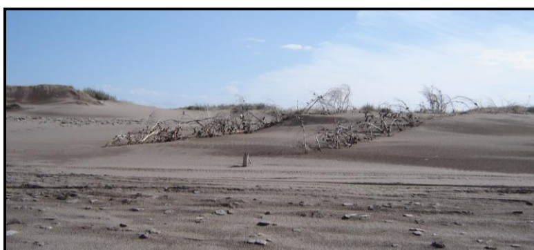
Figura 7 – Trampa de arena realizada en la zona este de Pehuen Co realizadas en el año 2005, consistió en la siembra de ramas, producto de podas del balneario, en forma perpendicular a la playa sobre el pie de médano frontal. Estas ramas hicieron las veces de trampa y acumularon a su alrededor arena generando pequeños médanos. Este proyecto se mantuvo sin ningún tipo de mantenimiento hasta fines del año 2009. Archivo personal de M. Luján Bustos (17/07/2008).
