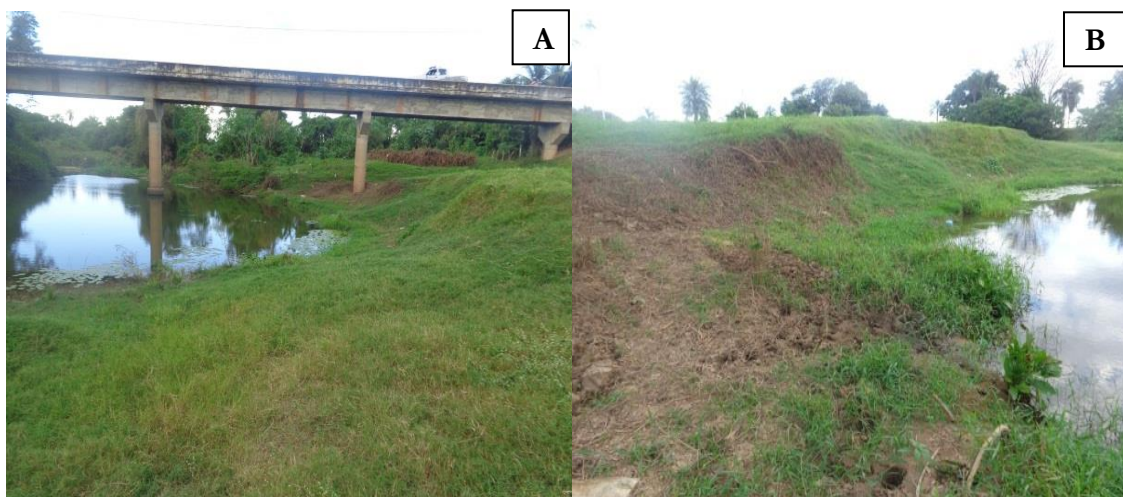
Figura 2 - Evidências da destruição da mata ciliar na área de estudo: (A) Na margem direita; (B) Na margem esquerda.
