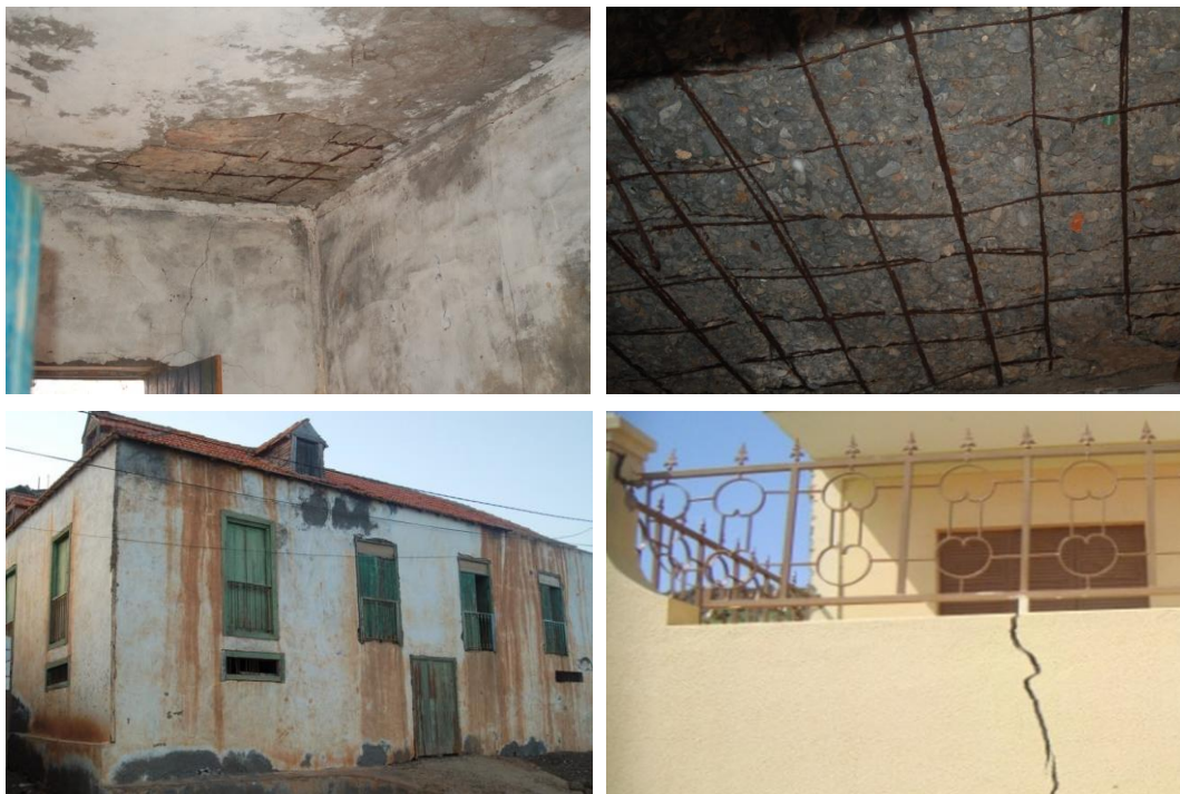
Figuras 9, 10, 11 e 12 (da esquerda para a direita) – Aspecto de tectos de residências onde se nota a contaminação do tecto como resultado da excessiva humidade e a insegurança do reboque e da estrutura de suporte do betão; Aspecto de um edifício muito antigo que representa múltiplos riscos para os residentes; Aspecto de edifícios com fissuras e que representam múltiplos riscos para os residentes.
