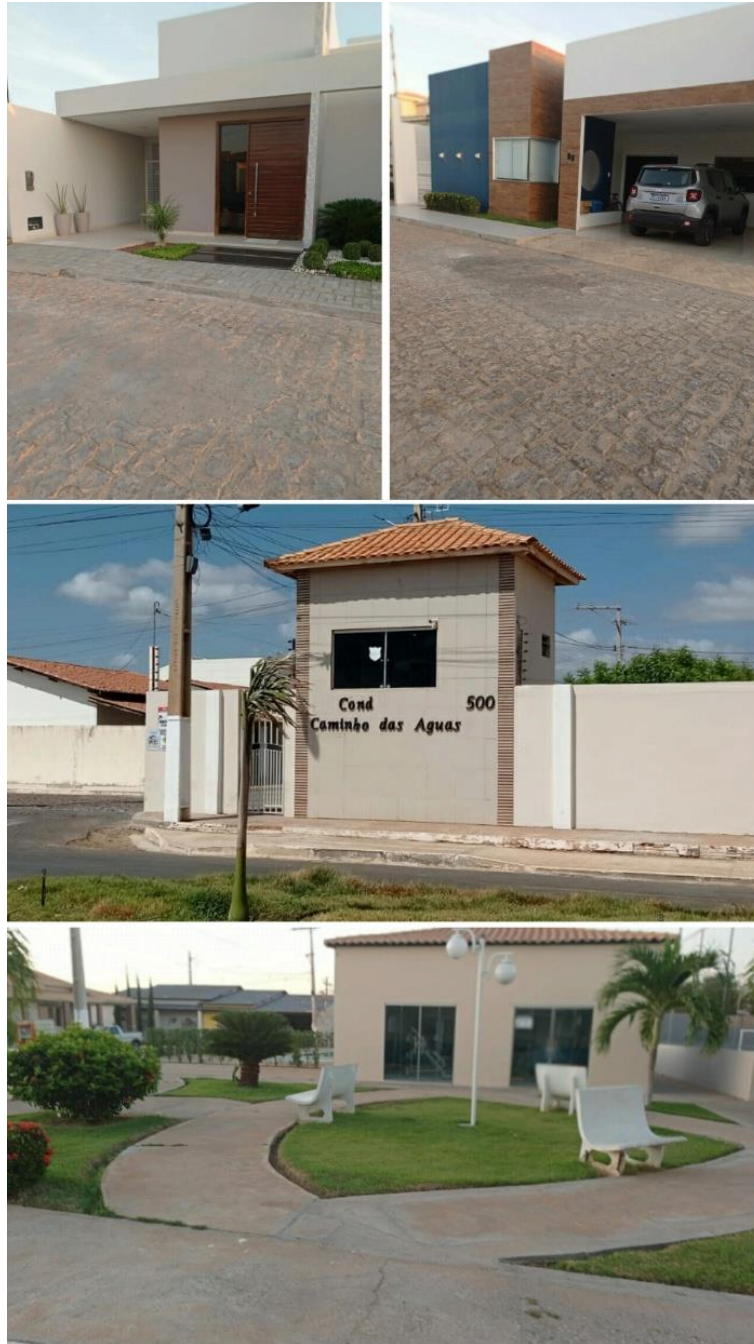
Imagem 2 – Casa Nova/BA: Condomínio Caminho das Águas
