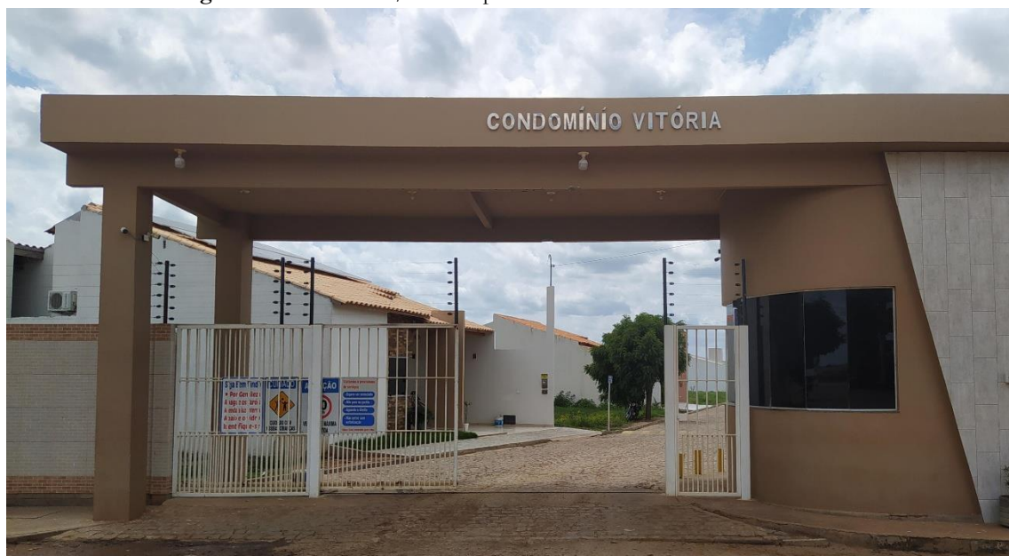
Imagem 03 – Casa Nova/BA: Empreendimento residencial fechado Vitória
