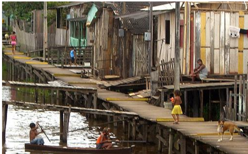
Figura 3 – Palafitas às margens do igarapé Altamira.
