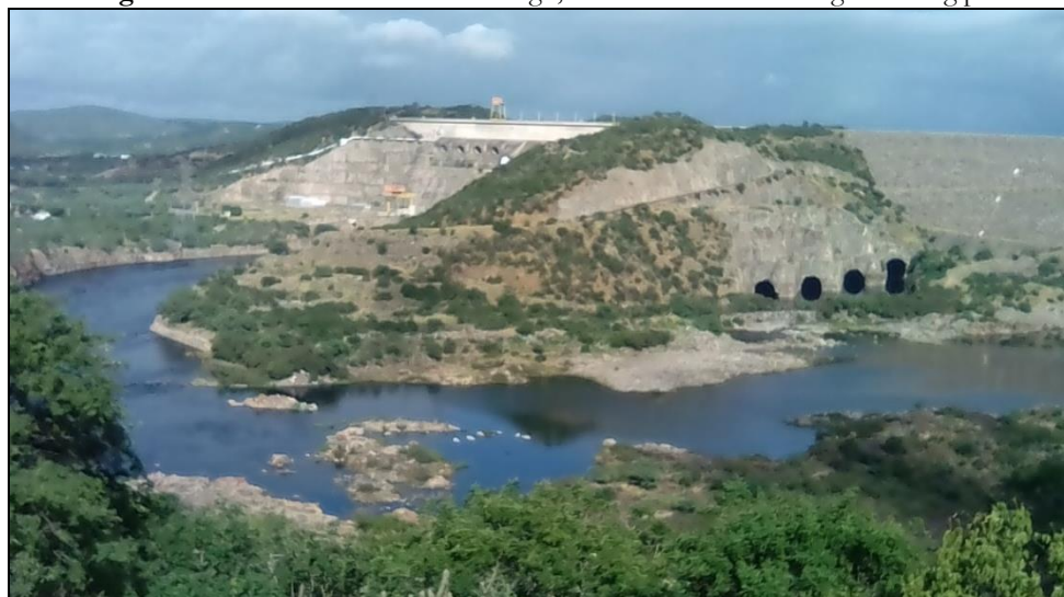
Figura 2 – Usina Hidroelétrica de Xingó, entre os estados de Alagoas e Sergipe
