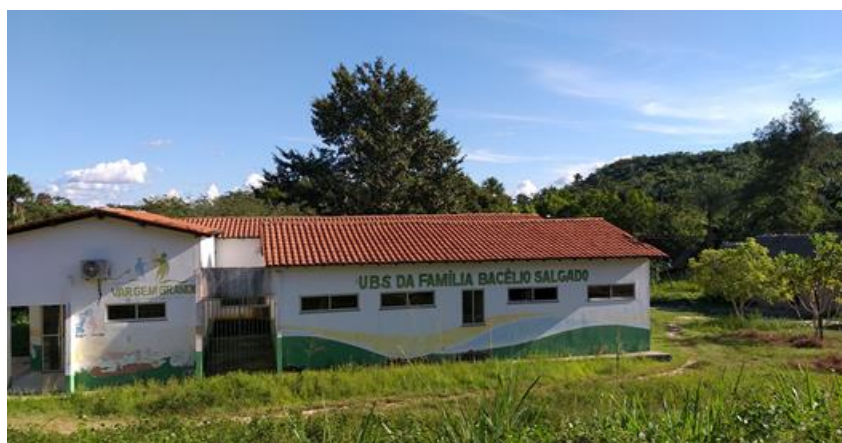
Figura 04 – Antiga escola que está sendo transformada em Museu
