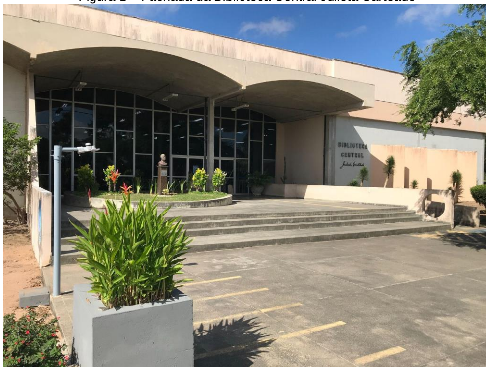
Figura 1 – Fachada da Biblioteca Central Julieta Carteado
